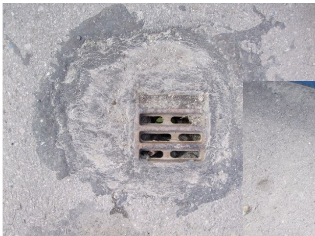
Widoczne wpusty pomostu niedrożne i o zbyt małej powierzchni odprowadzenia wody z nawierzchni
