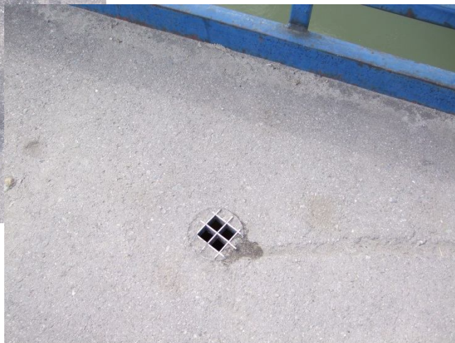
Widoczne wpusty pomostu niedrożne i o zbyt małej powierzchni odprowadzenia wody z nawierzchni
